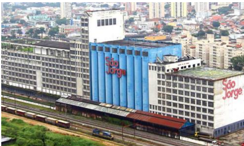
Figura 3: Foto do moinho em 2016, quando o edifício ainda estava abrigando as atividades da indústria. Fonte: https://www.dgabc.com.br/Noticia/1873157/producao-do-moinho-santo-andre-cai-70
